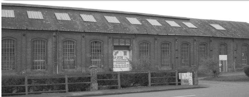
Fondée en 1875, la sucrerie Bertrand-Sarazin à Aulnois-sous-Laon a cessé son activité en 1914. Les bâtiments, caractéristiques des fabriques du XIXe siècle, sont aujourd'hui en partie restaurés et abritent les locaux de la communauté de communes du Laonnois, ainsi que quelques entreprises. © François Védrine
